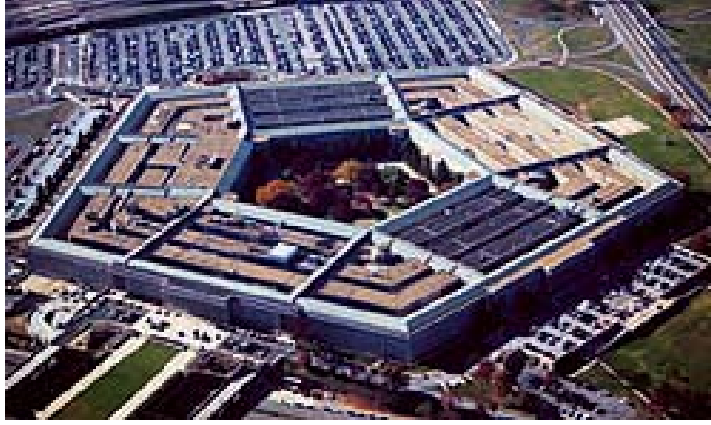
شكل (٢-٦٩) يبين مبنى البنتاجون قبل الانفجار ٨٣
